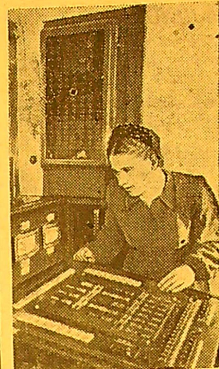
Sverdlovsko srityje į televaldymą pervesa keturios tarpinės stotys ir viena hidroelektrų stotis, esančios nuo dispečerinį punktų nuo 20 iki 100 km nuotolyje. Nuotraukoje: Nižnetagilsko elektros tinklo centro tarnybos dispečeris A. Karaseva prie tarpinės elektros stoties valdymo pulto. L. Velikžanino nuotr. (TASS).
