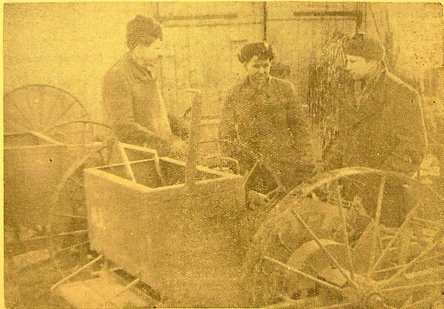
Zarasų MTS, inžinieriui-mechanikui žemės ūkio mašinoms drg. Krugliakovui vadovaujant, kalviai drg. drg. Dičiūnas ir Paprockas pritaikė bulvių sodinimo mašinos „SK-2“ kvadratiniam lizdiniam bulvių sodinimui.
