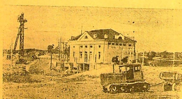
„Tautų draugystės“ hidroelektrinės statytojų kolektivas ruošiasi paleisti hidroelektrinę į darbą. Čia baigtos montuoti turbinos, iš esmės užbaigtas elektros laidų tiesimas, montuojami generatoriai, baigiami iрenginiai privėdamasis ir nuvedamasis kanalai, galutinai nudažinamas pagrindinis hidroelektrinės pastatas.
